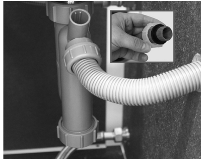
Abb. 8: Montage des Kondensatschlauchs
