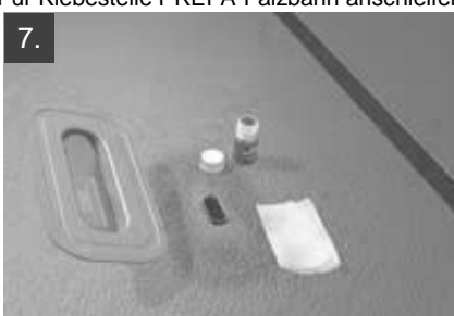
7. Angeschliffene Klebestellen mit Haftreiner reinigen
