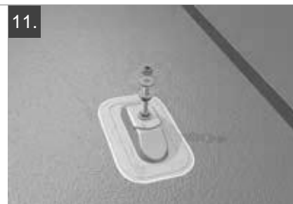
11. Scheiben und Flanschnutter anbringen.
