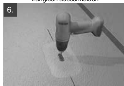
6. Mittig im Langloch vorbohren, Ø 8 mm
