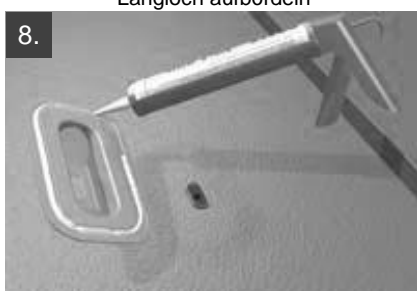
8. Naht (Ø=10 mm) auf angeschliffenen und gereinigten Solarhalter auftragen
