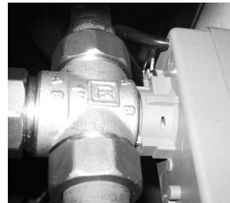
6. Das Gerät entlüftet automatisch, wenn die Entlüfter (schwarze Kappe) offen sind. Wird der Heizkreis befüllt oder entleert, öffnen sich die Entlüftungsventil.
