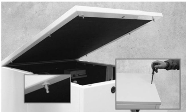
Abb. 5: Demontage der oberen Verkleidung
