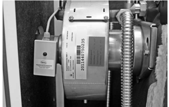
Abb. 22: Werkseitig montierter ATB
