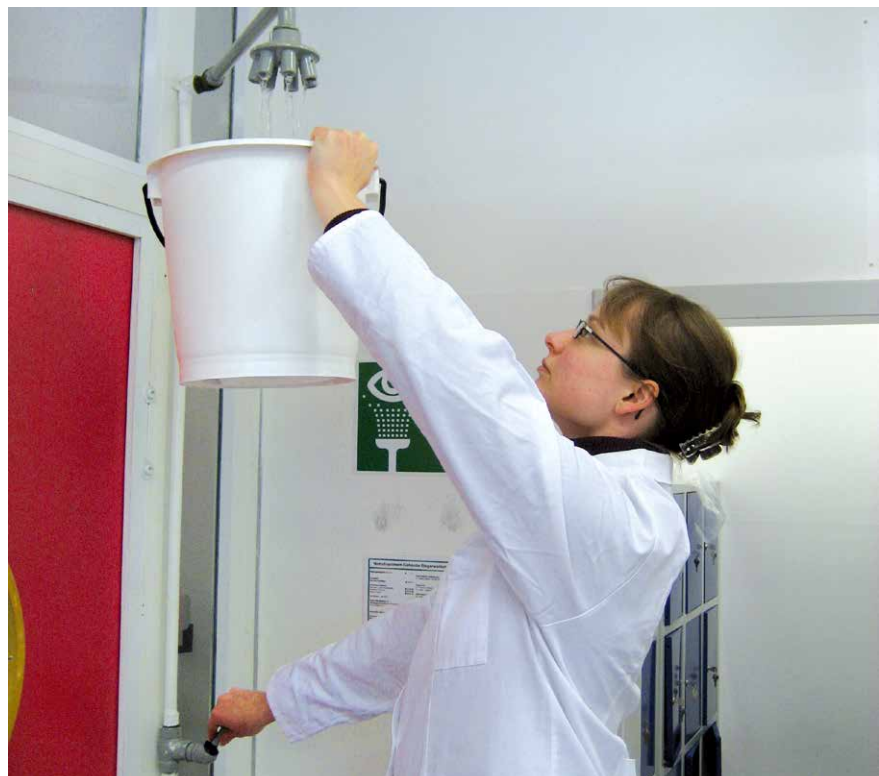
Personalintensiver Wasserwechsel an jeder endständigen Entnahmestelle. Heutzutage übliche, aber ineffektive und teure Lösung, um den bestimmungsgemäßen Betrieb im Gebäude sicherzustellen.
