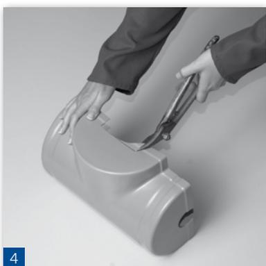
Möglichkeit 2: Trennen Sie die Ummantelung vom PU-Schaumkern und schneiden Sie die PS-Schale entlang der Markierung mit einer Blech- oder Kunststoffschere aus.
