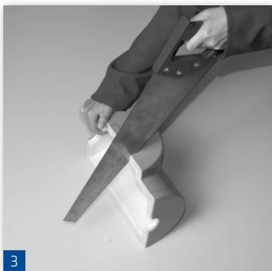
Möglichkeit 1: Nehmen Sie eine Säge und sägen Sie entlang der Markierung.
