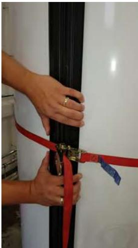
4. Verbinden Sie die Isolierungen mit dem Klicksystem. Die Montage wird erleichtert, wenn (wie auf dem Foto ersichtlich) ein Spanngurt verwendet wird.
