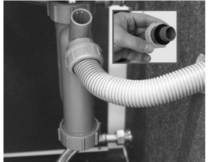
Abb. 8: Montage des Kondensatschlauchs
