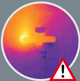
Mischarmatur angebunden über Doppelwandscheiben. (Temperatur > 60° C)
