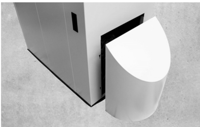
Abb. 58: Demontage der Brennerhaube
