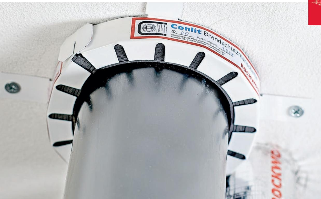
Die Conlit Brandschutzmanschette für die Abschottung von Kunststoff-abwasserleitungen besteht aus dem Brandschutzmanschettengehäuse, das im Inneren in mehreren Lagen mit einem hochwirksamen intumeszierenden Baustoff ausgestattet ist. Im Brandfall reagiert der aufschäumende Baustoff und verschließt die Bauteilöffnung dauerhaft gegen Durchtritt von Feuer und Rauch.
