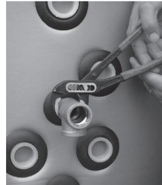
3. Das Gewinde des flexiblen Wellrohres aufdichten und in das T-Stückes einschrauben.
