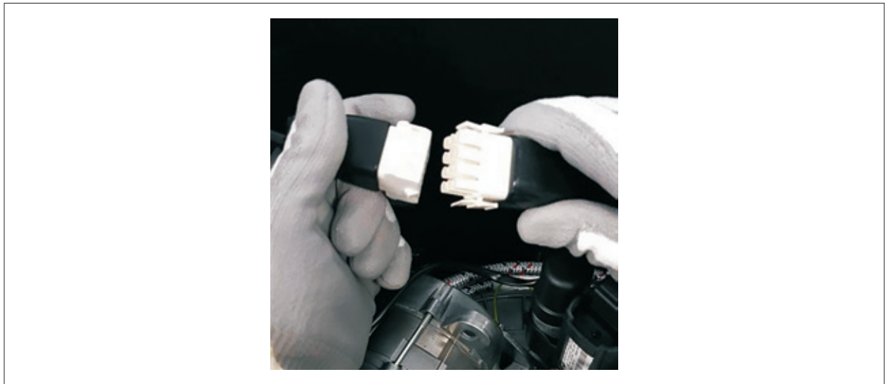
Abb. 4.3 Brennerstecker abziehen
