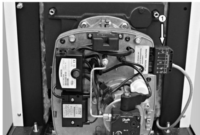
Abb. 12: Montage des Euro-Anschluss-Steckers ①
