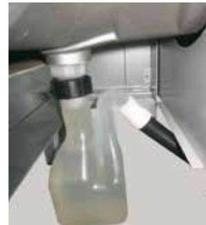
Zweiten Siphon an den Stutzen der Kondensatfalle montieren
