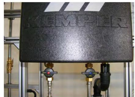
Bild 8 - Wasserseitige Absperrung
