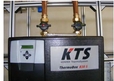
Bild 7 - Absperrung der Heizungsseite
