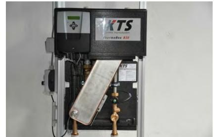
Bild 1 - KTS ThermoBox ohne Verkleidung
