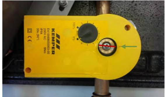
Bild 20 – Stellantrieb im geschlossenen Zustand
