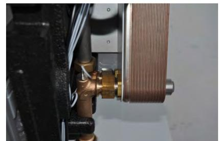
Bild 13 - untere Verschraubung PWÜ
