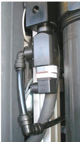
Abb. 2: Einbau Leitfähigkeitsmess-einrichtung
