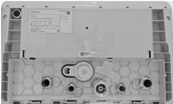
Abb. 10: Montierter Gaskugelhahn um 45° nach rechts gedreht
