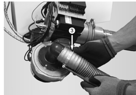
Abb./Fig. 17: Am Ansaugstutzen des RLU Anschluss-Stücks montierter Zuluftschlauch Tuyau d'admission d'air monté sur le collecteur d'admission de la pièce de raccordement étanche LAS
