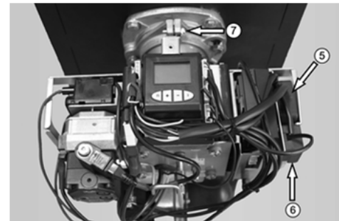
Abb./Fig. 16: Euro-Anschluss-Stecker ⑤+⑥ sowie Klemm- flansch ⑦ Connecteur Euro ⑤+⑥ ainsi que la bride de serrage ⑦
