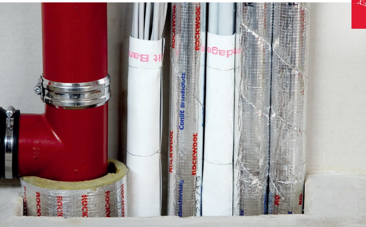
Die Conlit Bandage besteht aus einem Trägergewebe, das auf beiden Seiten mit einem unter Hitzeeinwirkung aufschäumenden Material beschichtet ist. Sie wird für die Abschottung von Elektroleitungen der Feuerwiderstandsklasse S30 bis S90 eingesetzt. Die Conlit Bandage ist etwa 1 mm dick und flexibel. Dadurch lassen sich auch enge und schwer zugängliche Bereiche wirkungsvoll abschotten.
